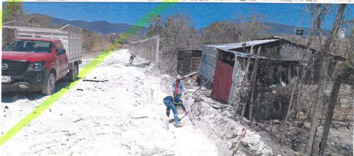
OBRA: EP BENITO JUAREZ, LOC. TLAMACAZAPA, MPIO. DE TAXCO, GRO.
