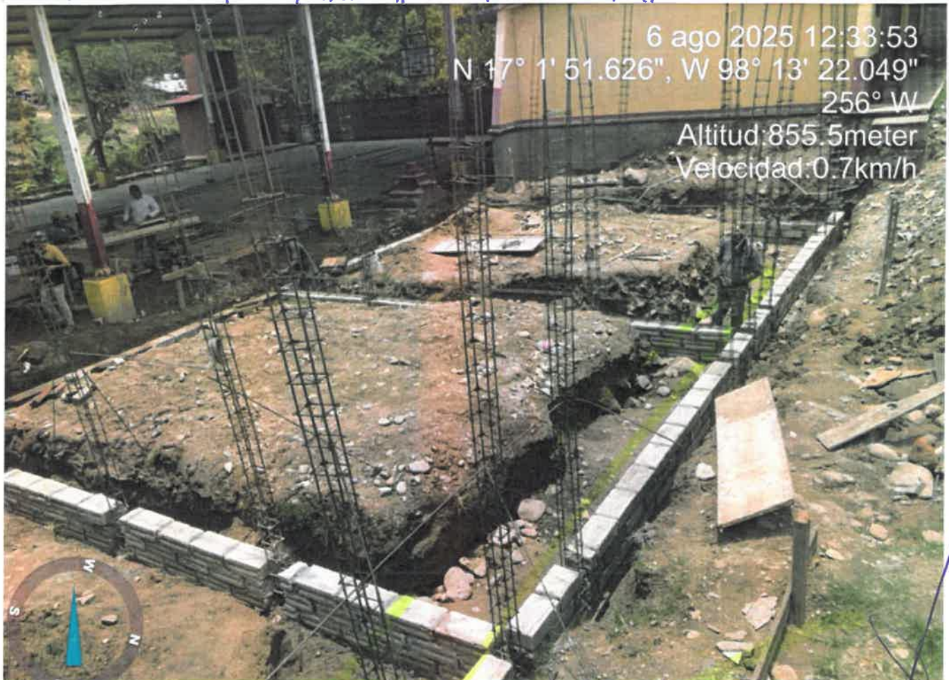
CONSTRUCCION DE ZANALAS EN EST. REG. 751 T/C 6.00X8.00 MTS
