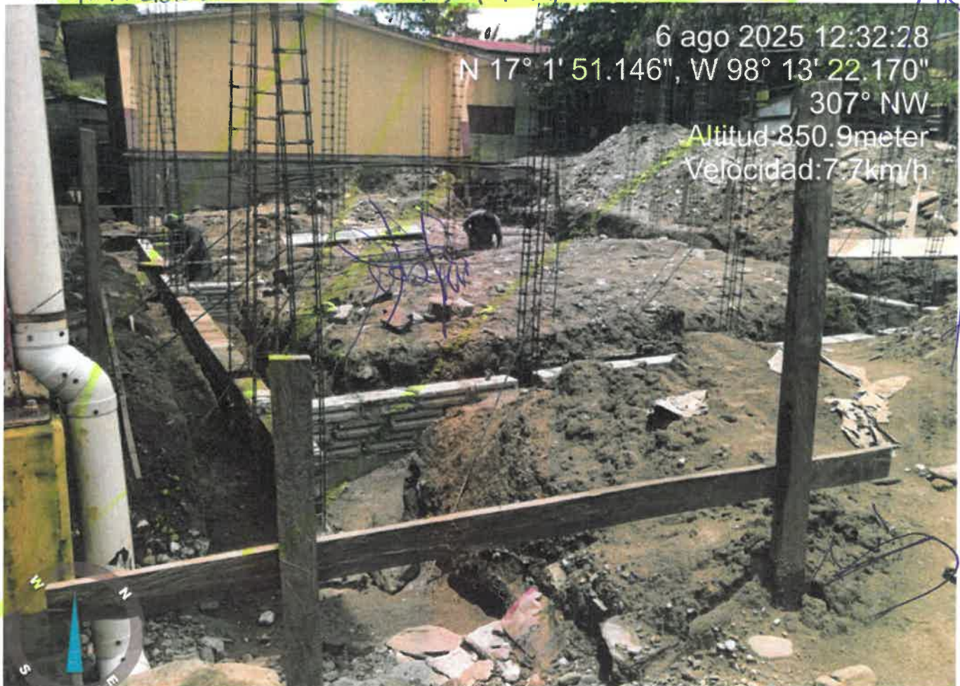
CONSTRUCCION DE ZANALAS EN EST. REG. 751 T/C 6.00X8.00 MTS
