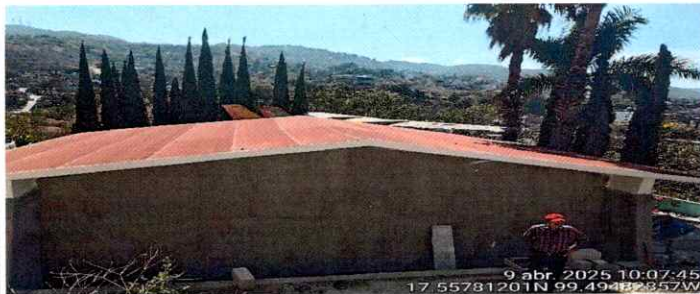
Concepto revisado: Impermeabilizante ya Terminado de la Aula de Usos Múltiples del Edificio "F"
