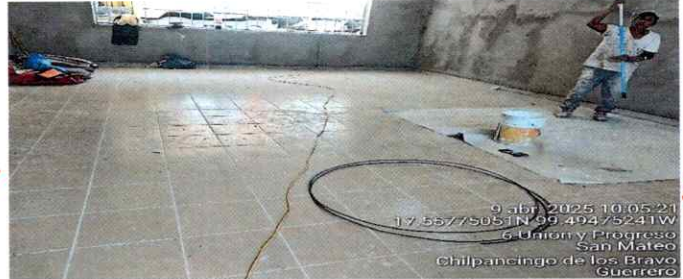
Concepto Revisado: Piso de Loseta ya terminado de la Aula de Usos Múltiples del Edificio "F".
